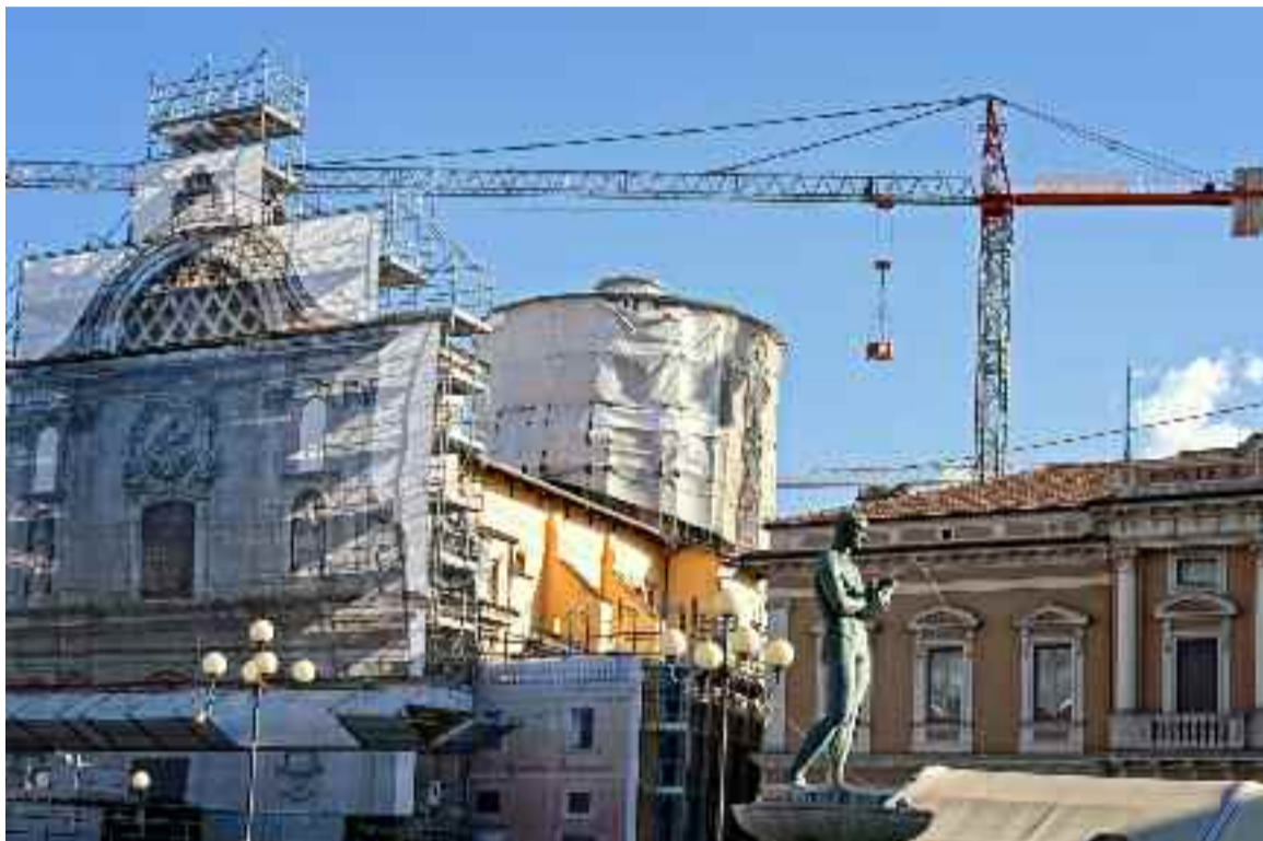
Un cantiere della ricostruzione a L'Aquila
